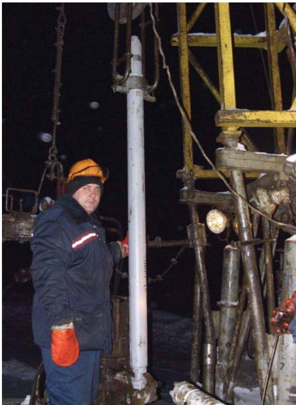
Рис. 2. Монтаж погружного вентильного электродвигателя серии ВЭДБТ
